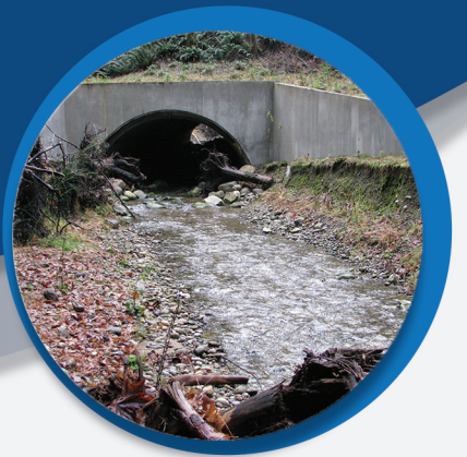
NAVFAC REPLACE CULVERT
